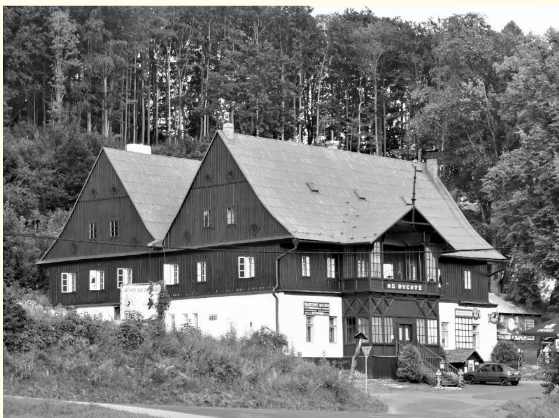
Obr. 3. Malá Morávka, čp. 59, rychta, stav v srpnu 2020. Foto Pavel Šopák.
