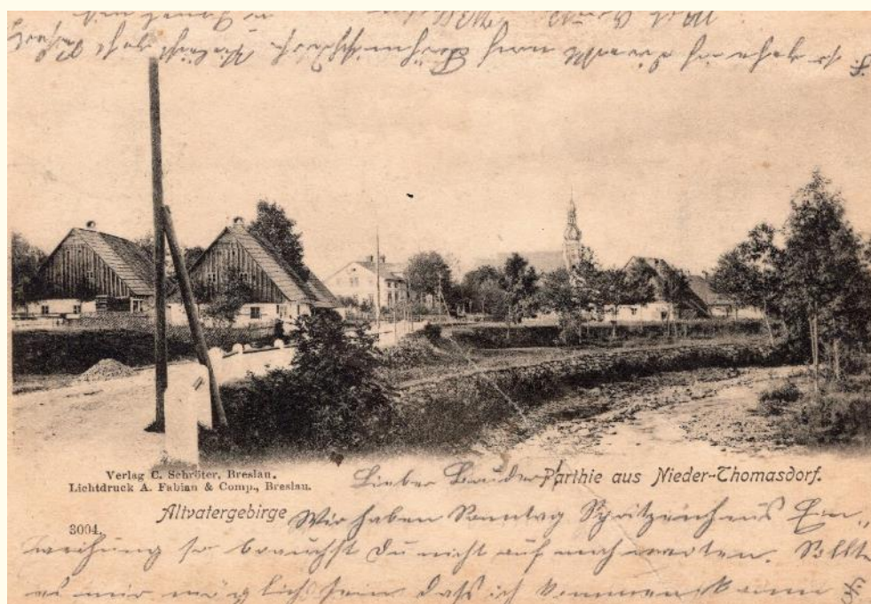
Obr. 5. Již upravené koryto řeky v Dolním Domašově. Schröter 1899, sb. autora.
