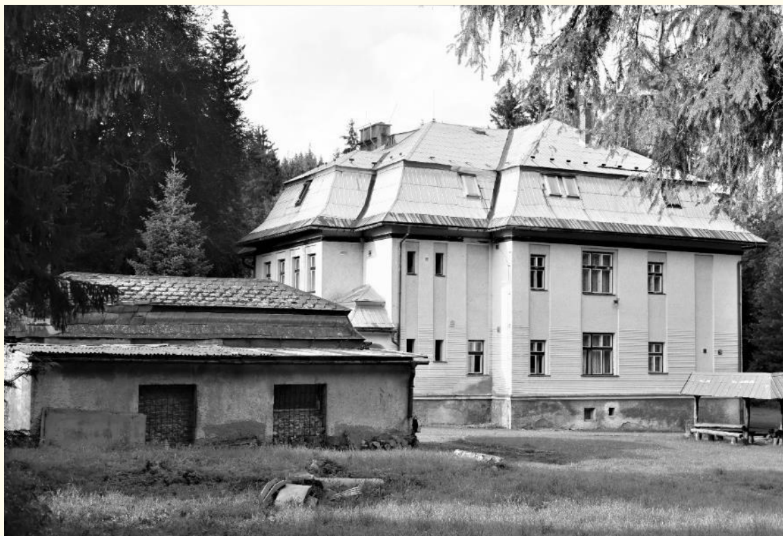
Obr. 2. Karlov pod Pradědem, čp. 84, Nová Olbrichova vila, realizace před 1914, stav v srpnu 2020. Foto Pavel Šopák.
