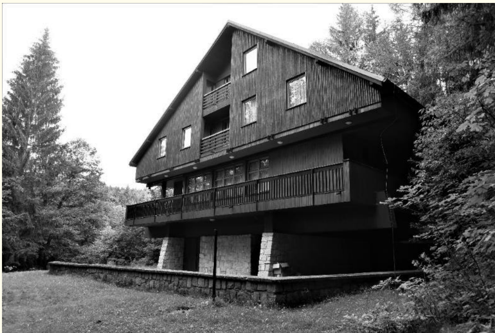
Obr. 10. Karlov pod Pradědem, bývalá chata okresního národního výboru v Bruntále, stav v srpnu 2020. Foto Pavel Šopák.
