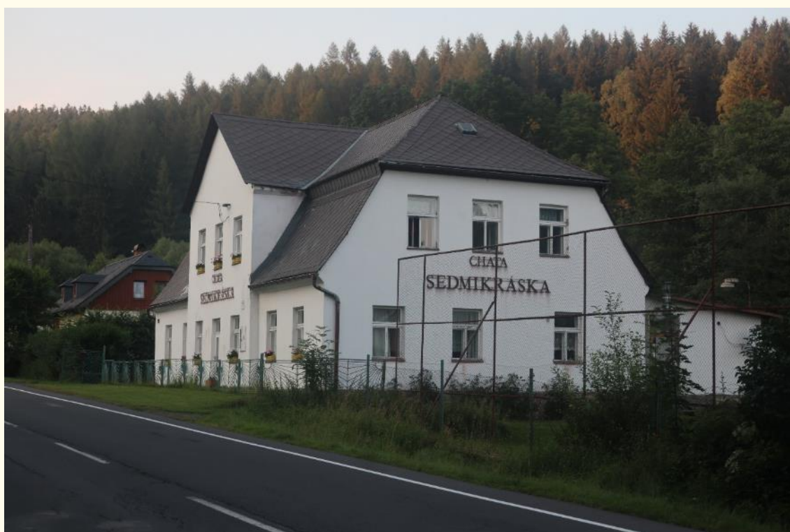
Obr. 12. Malá Morávka, čp. 97, stav v srpnu 2010. Foto Pavel Šopák.
